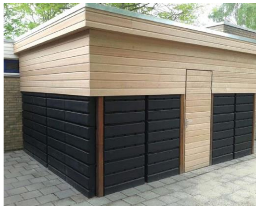
Regenwateropslag in de berging
