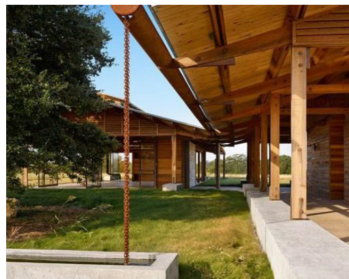
Zichtbaar afvoeren regenwater via waterketting
