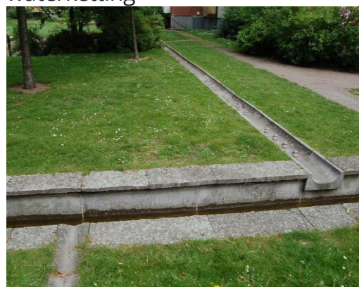
Zichtbaar afvoeren regenwater via open goten
