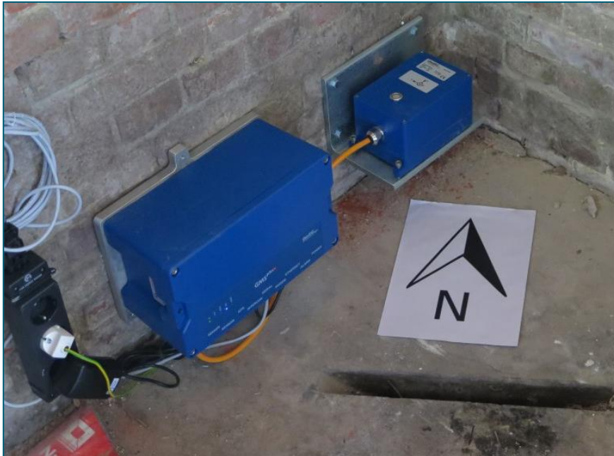
Afbeelding 4.95 Trillingsmonitoring system (TNO)– data opnemer (links) en sensor (AC-73 Force Balance Accelerometer) (rechts)
